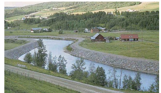
Figur 5: Flomdiker bygget for å hindre oversvømmelse av elveslette
