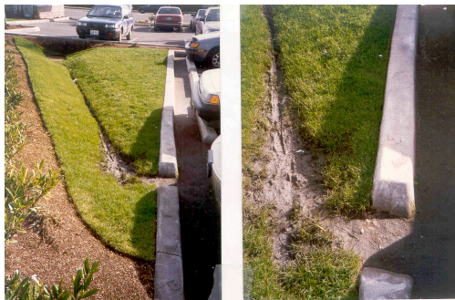
Figur 8: Overvannshåndtering på en parkeringsplass i Seattle, USA.
