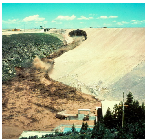
Figur 5: Dambrudd ved Teton Dam i USA i 1978 (Kilde USGS)
