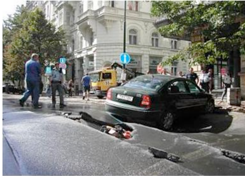
Figur 3.1: Svikt i veifundament på grunn av lekkasje i VA-anlegg
